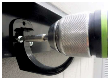
Fot. 4-27. Montaż uchwytych rynnowych.
