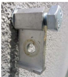
Fot. 4-37. Wspornik obejmy rury spustowej.
