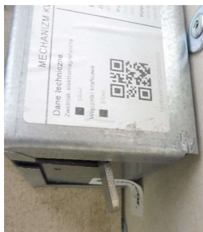
Fot. 3-57 Dźwignia ręcznego zamykania klapy p.poż
