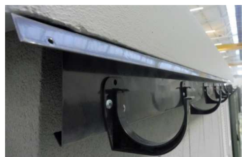
Fot. 4-28. Zamontowane uchwyty rynnowe.
