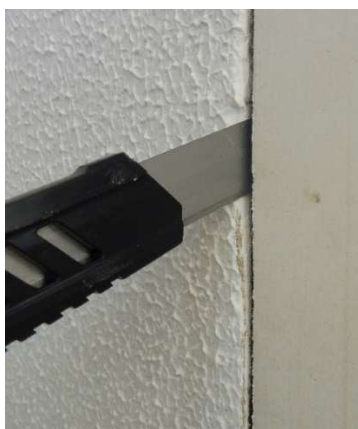
Fot. 3-50 Cięcie obrysu płyty promatect.
