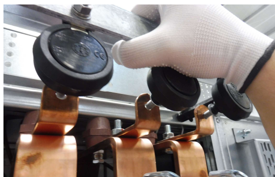
Fot. 5-5 Montaż szyny z ogranicznikami przepięć
