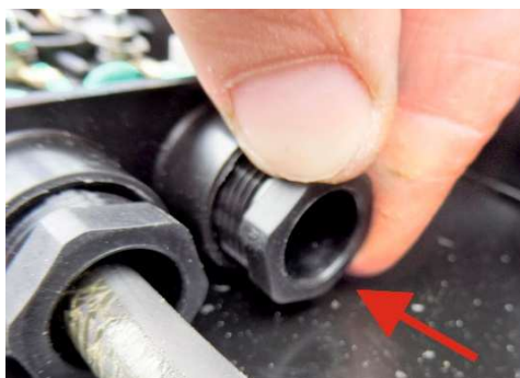
Fot. 4-53 Odkręcanie dławika przy obudowie puszkii zasilającej
