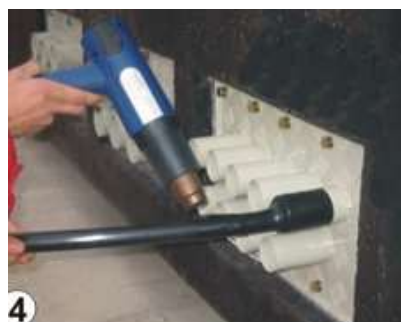
Fot. 6-29. Montaż kabla w przepuście (4).
