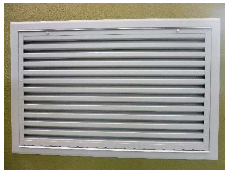
Fot. 11-10 Żaluzja z włókniną filtracyjną widok z zewnątrz stacji
