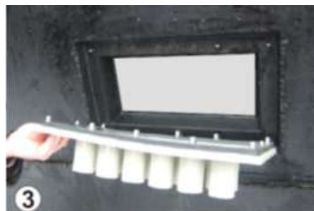
Fot. 6-24. Montaż przepustu kablowego (1).
