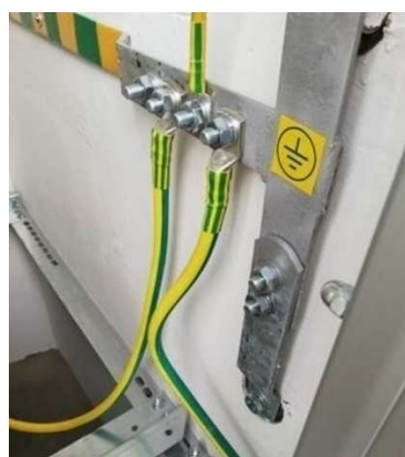
Fot. 3-20 Złącze kontrolne.
