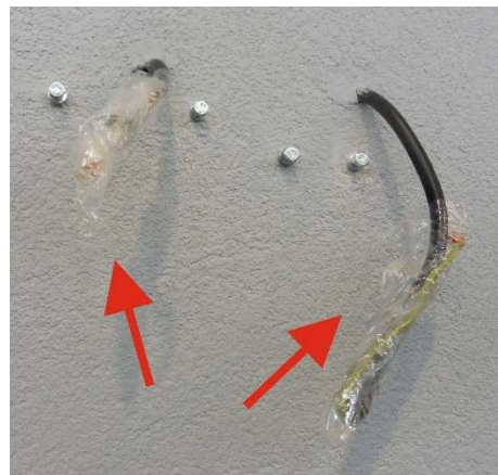
Fot. 4-10. Przewody zabezpieczone na czas transportu.
