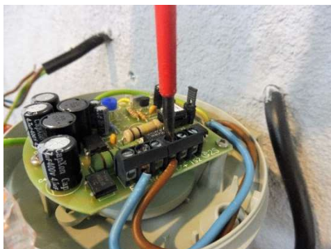
Fot. 4-13. Łączenie przewodów.
