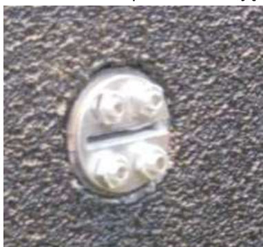
Fot. 3-22 Widok w fundamencie przepust bednarki.
