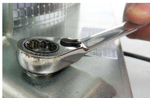
Fot. 4-50 Montaż wentylatora
