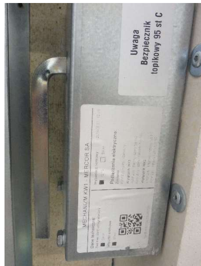
Fot. 3-55 Klucz w położeniu otwartej klapy
