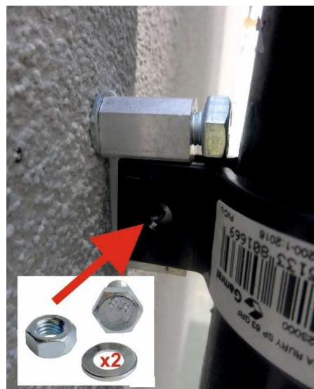
Fot. 4-38. Montaż obejmy rury spustowej.
