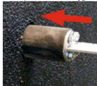
Fot. 3-24 Montaż przepustu bednarki (1).
