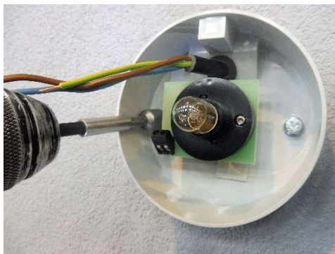
Fot. 4-21. Montaż lampy.
