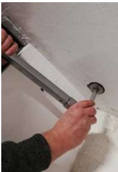
Fot. 3-31 Dokręcanie przepustu uziemienia.
