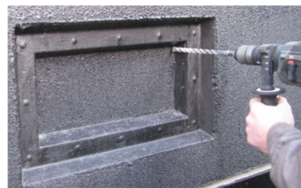
Fot. 6-17. Wiercenie otworów.
