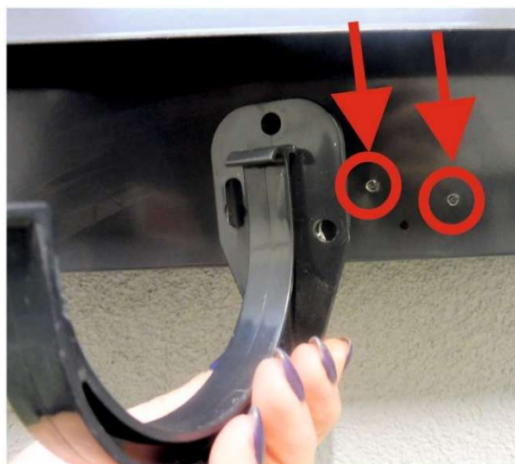
Fot. 4-26. Otwory pod montaż uchwytych rynnowych.
