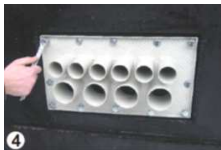
Fot. 6-25. Montaż przepustu kablowego (2).
