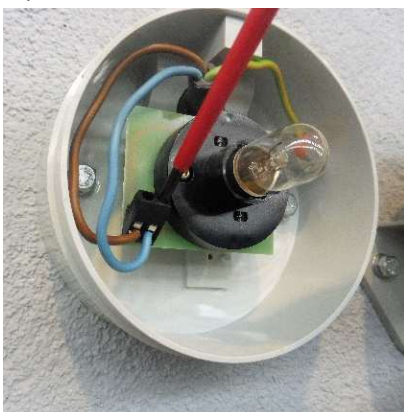
Fot. 4-23 Łączenie przewodów.
