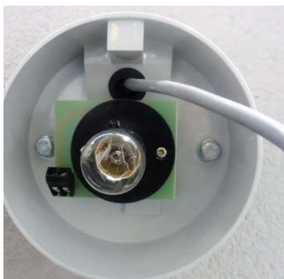
Fot. 4-22. Montaż lampy.
