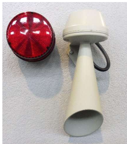
Fot. 4-15. Zamontowana sygnalizacja optyczno-akustyczna.
