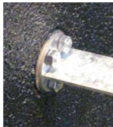
Fot. 3-25 Montaż przepustu bednarki (2).
