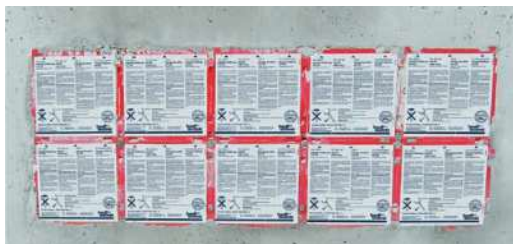
Fot. 6-33. Zamontowane przepusty w fundamencie .
