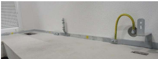
Fot. 3-13 Otok stalowy ocynkowany.
