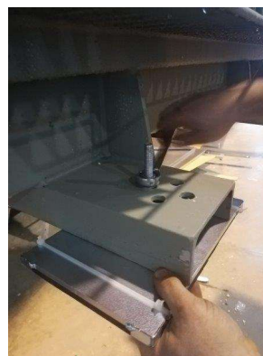
Fot. 3-10 Montaż stopy pod transformator.
