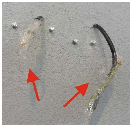
Fot. 4-18. Przewody zabezpieczone na czas transportu.
