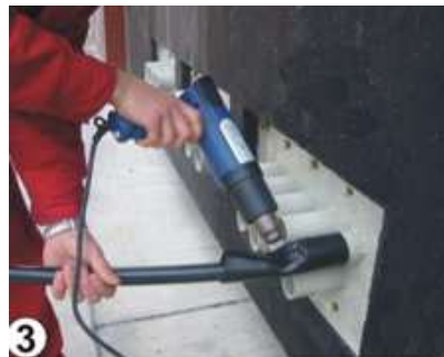
Fot. 6-28. Montaż kabla w przepuście (3).
